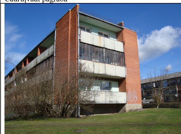
Ēkas fasādes ar lodžijām
