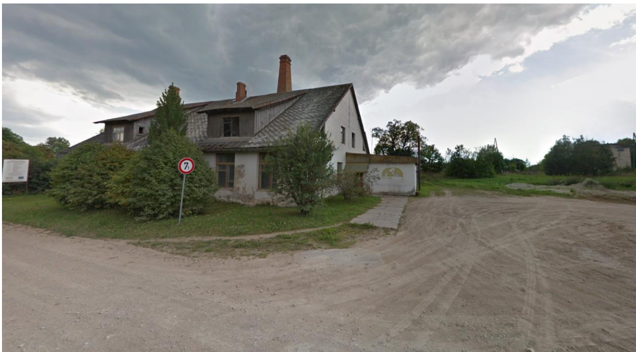
4.attēls Skats uz lokālplānojuma teritoriju no Skolas ielas Ērberģes ciemā
