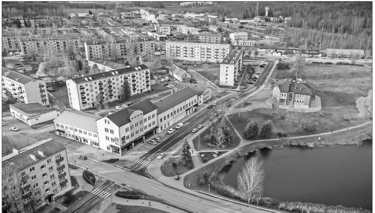
GĀJĒJU UN BRAUCĒJU ĒRTĪBĀM Skolas ielā Aizkrauklē izveidotas plašas un ērtas autostāvvietas un gājēju celiņi.
